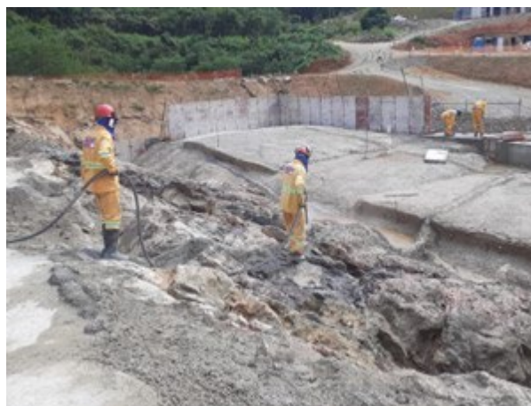
Foto 7: Desemboque: Segue limpeza de topo rochoso com espingarda de ar pressurizado (28/10/2022).
