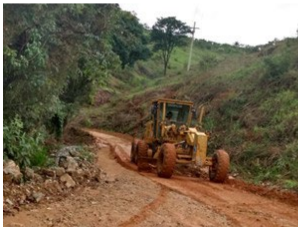
Foto 13 : Manutenção no sistema drenagem provisório do acesso a margem esquerda (06/12/2022).
