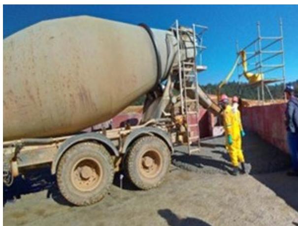
Foto 8: Concretagem no platô 592 - 21/11/2022.
