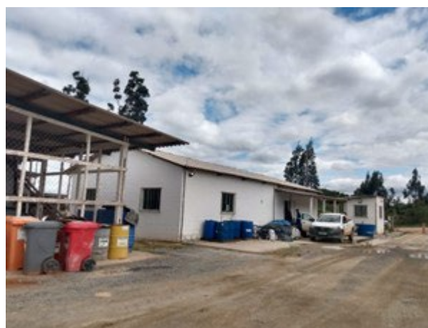
Foto 2: Situação atual das Estruturas no Canteiro operacional (26/10/2022)
