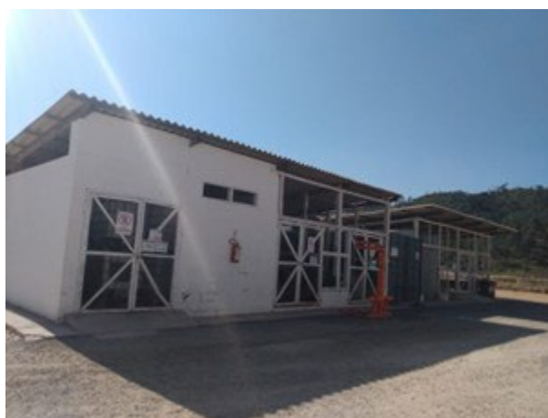
Foto 3: Situação atual das Estruturas no Canteiro operacional (28/11/2022)
