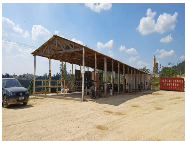
Foto 1: Situação atual das Estruturas no Canteiro operacional (22/09/2022)
