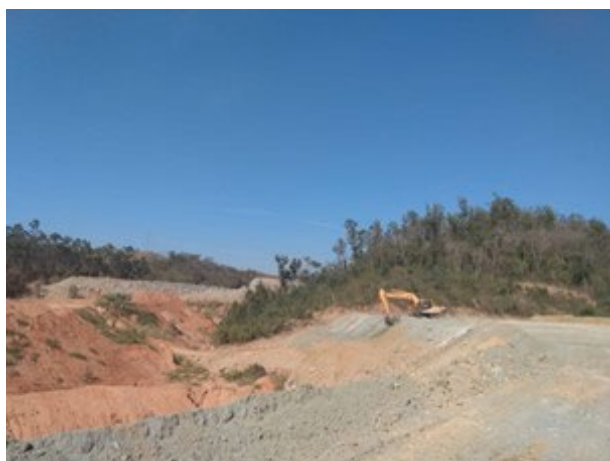
Foto 10: I Manutenção no sistema drenagem provisório do bota fora 2b margem esquerda 02/09/2022.
