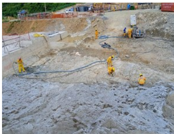
Foto 9: Continuidade na limpeza rigorosa fina manual sobre topos rochosos com auxílio de espingarda de ar pressurizador no bloco 2 do platô 595 - 21/12/2022.
