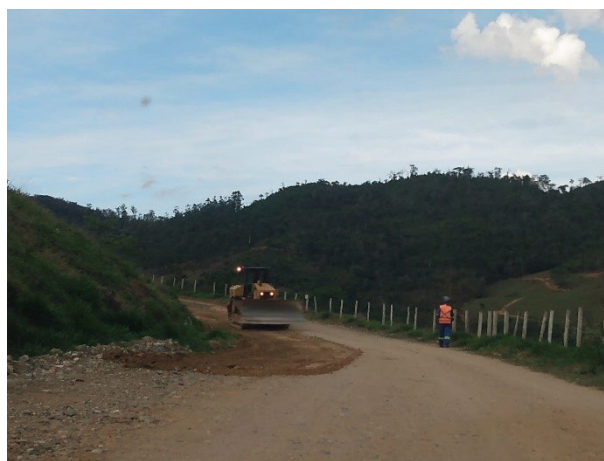
Foto 11: Manutenção no sistema drenagem provisório do acesso MD01 07/10/2022.
