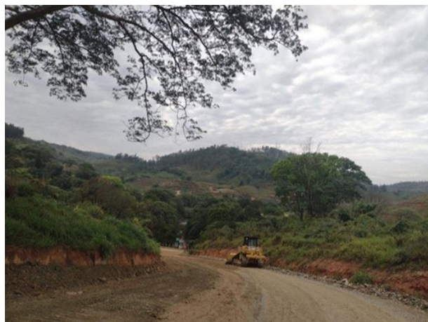
Foto 12 : Manutenção no sistema drenagem provisório do acesso MD01 (01/11/2022).
