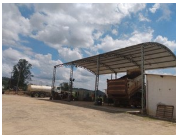
Foto 4: Situação atual das Estruturas no Canteiro operacional (20/12/2022)
