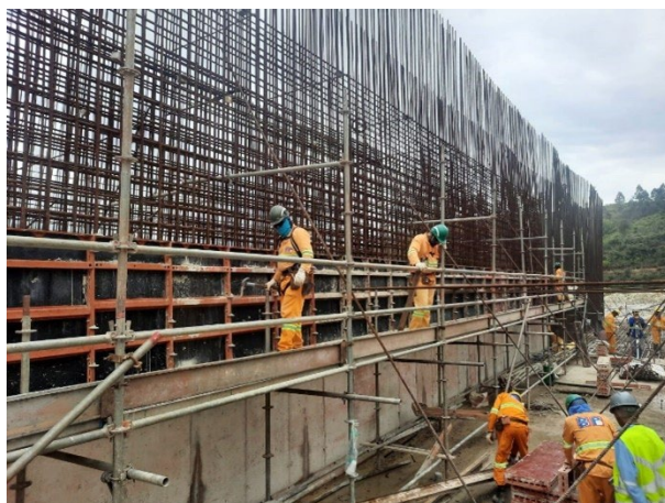
Foto 6: Módulo 1: Início de fechamento de forma da 2ª fase da parede central 27/09/2022.
